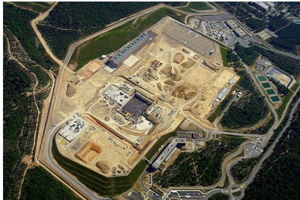
Az ITER építési területe a levegőből (Franciaországban épül, nemzetközi összefogással.)
